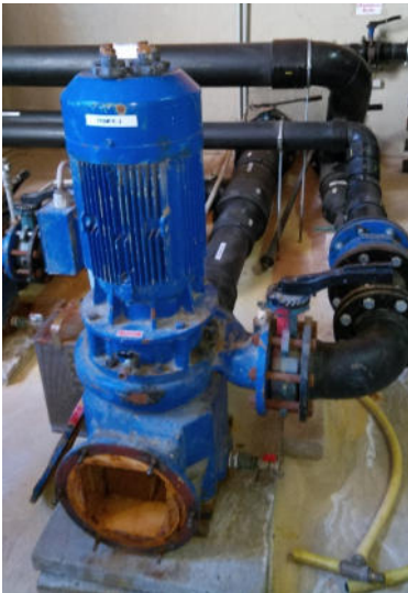
Alte Ölmwälpumpe im Freibad
